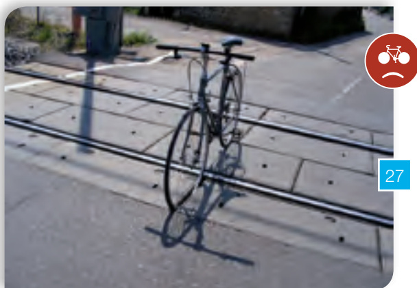
Écartement trop important entre les dalles (chute par blocage de route).
