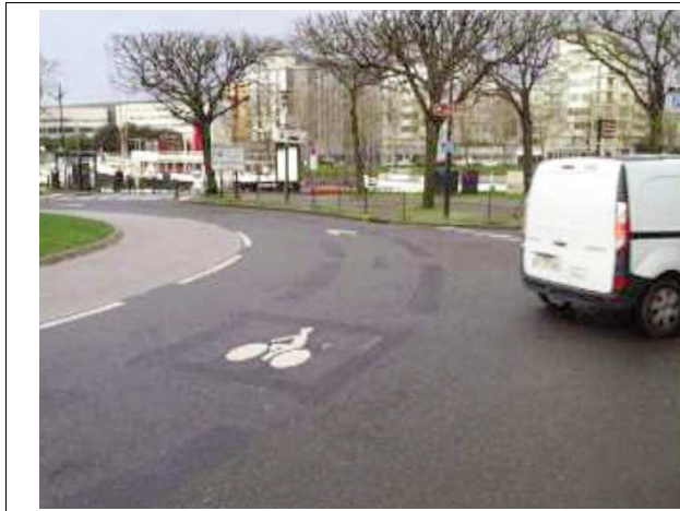
Nantes : marquage au centre de l'anneau d'un giratoire
